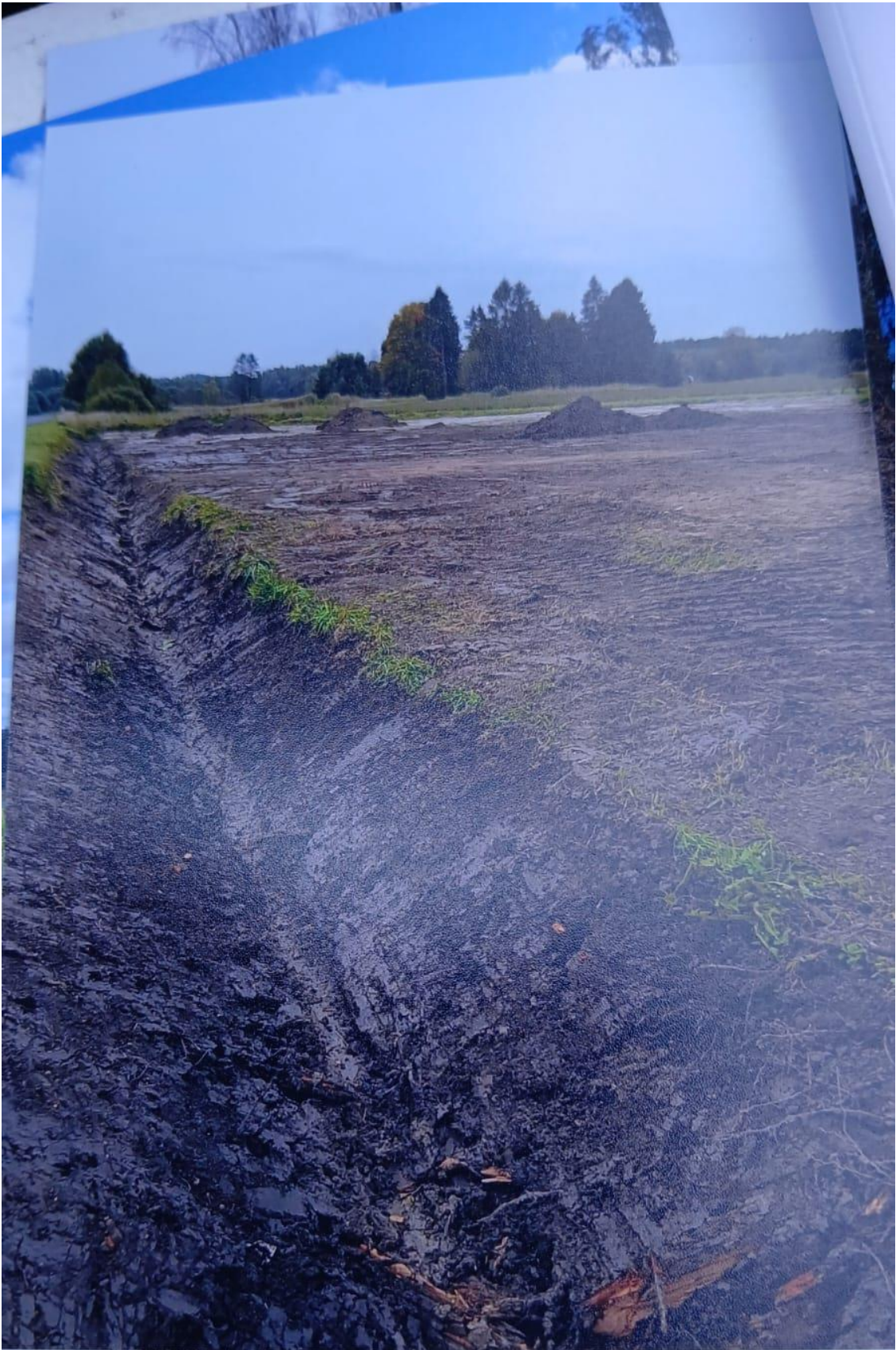
Omanik omadel kuludel parandas kraavid, paigaldas truubi .
